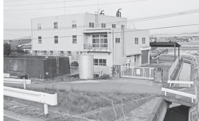
氷川排水機場
