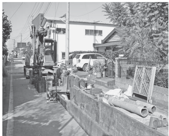
公共工事現場（下水道管渠工事）
