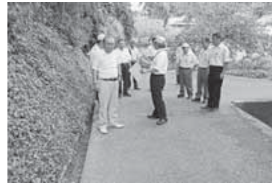
町道芝原2号線道路維持修繕工事
