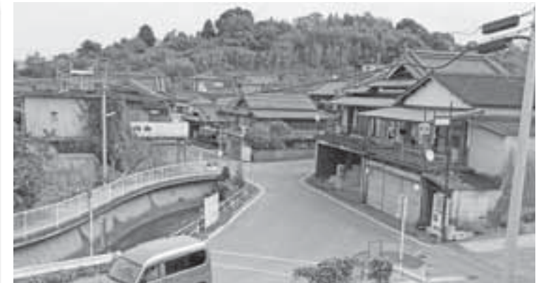
改修要望がある町道太尾線
