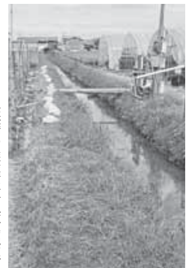
未整備の農業排水路(鹿島地区)
