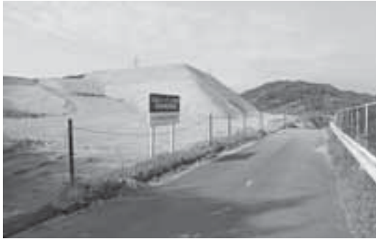
インターチェンジの予定地にある元旦ビューティー
