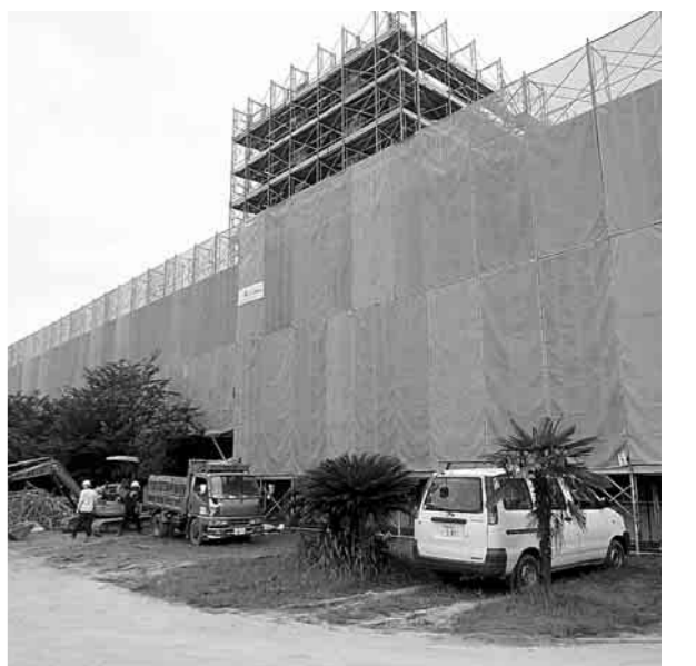
竜北東小学校校舎耐震工事及び大規模改造工事
