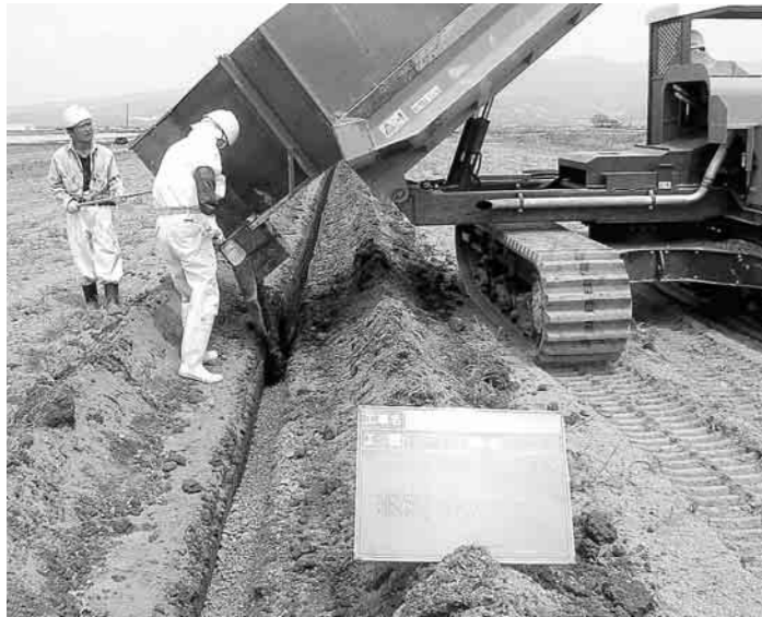
農業体質強化基盤整備事業 (客土、暗渠排水工事)
