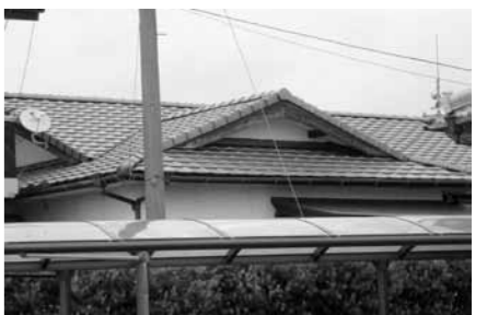
住宅リフォームで施工した屋根
