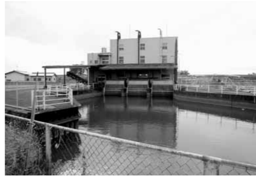
氷川排水機場
