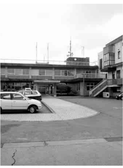
図書館が建設される 宮原振興局旧本館部分
