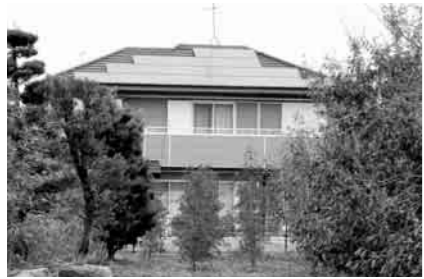
ソーラーパネルを設置した住宅
