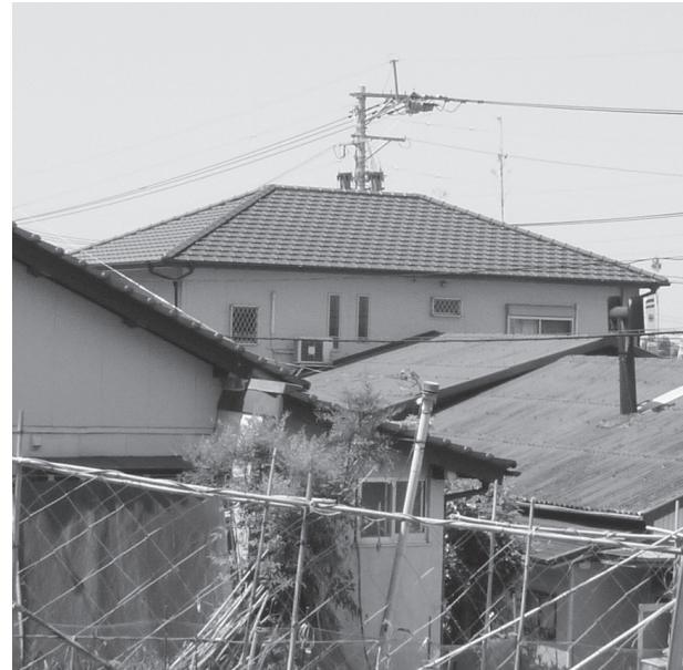
住宅リフォームで屋根瓦改修
