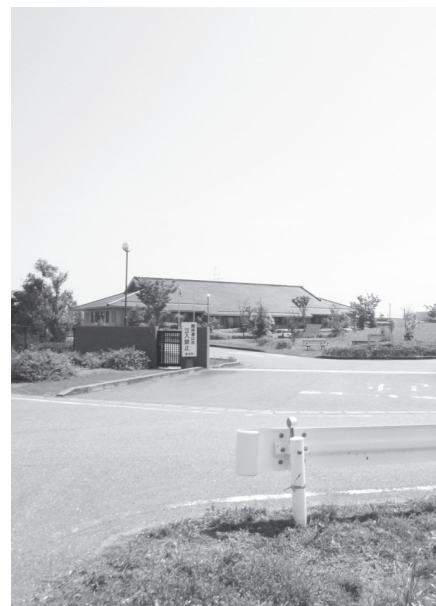
八代北部浄化センター
