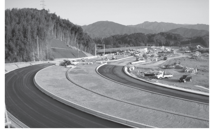
工事が進むスマートインターチェンジ（高塚地区）
