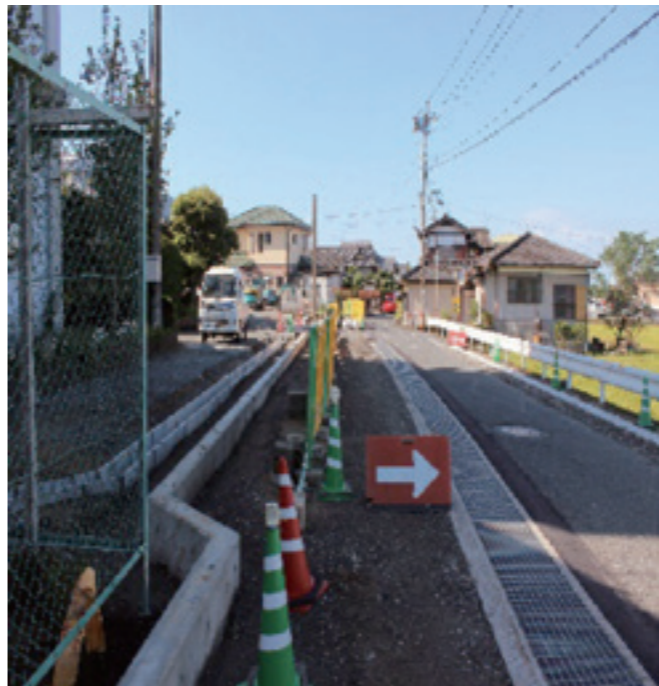
宮原小学校正門前工事
