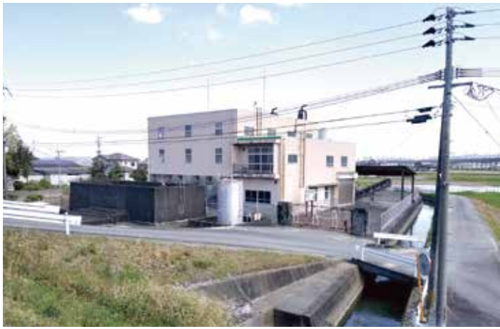
氷川排水機場
