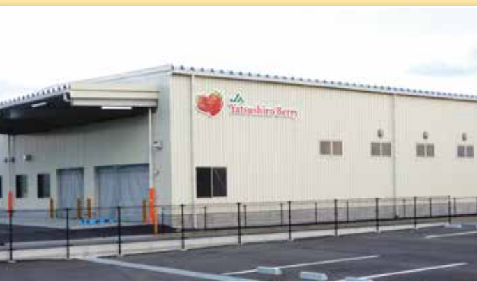
JAやつしろ苺パッケージセンター完成
