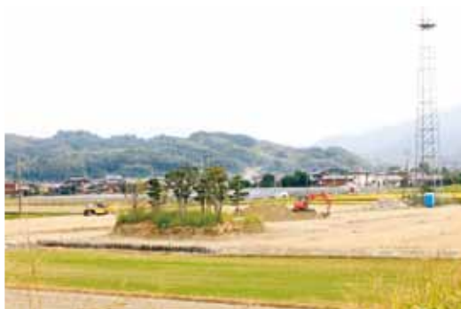
整備が進む野津防災公園（仮称）
