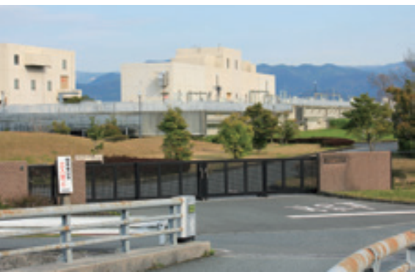
八代北部浄化センター
