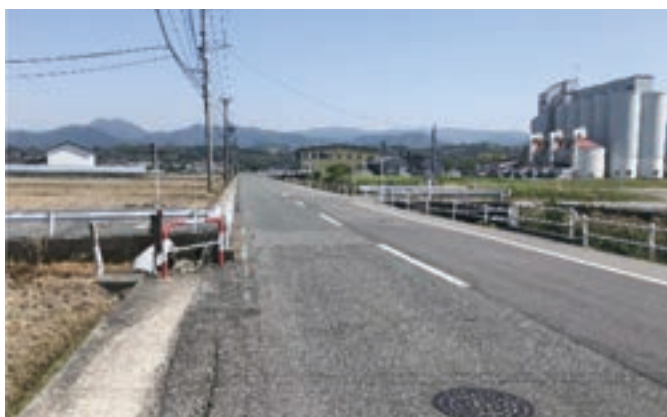
町道改良工事(町道北川反南北鹿野線)
