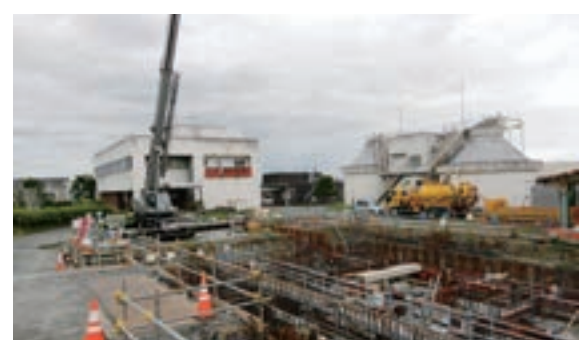
中継ポンプ場建設（宮原浄化センター内）
