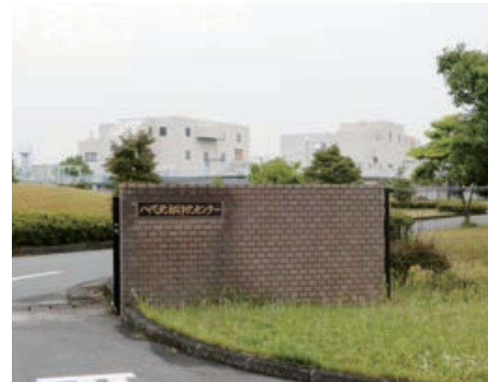
八代北部浄化センター
