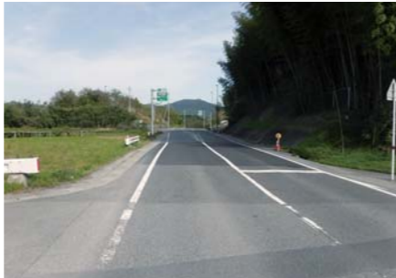
町道吉本本山線道路舗装補修工事
