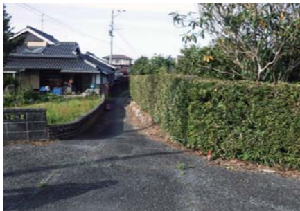
町道梅6号線道路改良工事
