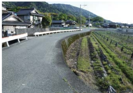
町道旧国道2号線道路改良工事
