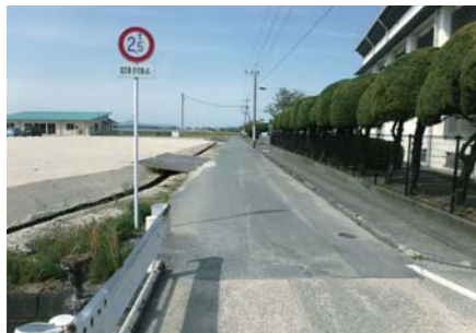
町道南北の割線道路舗装工事
