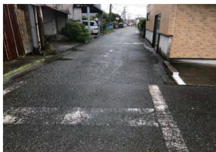
町道大川線道路舗装工事
