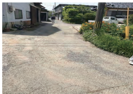
町道来上1号線ほか道路舗装工事
