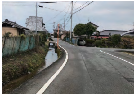
町道早津南部集会所線道路側溝改修工事
