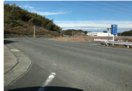
町道吉本本山線道路舗装補修工事
