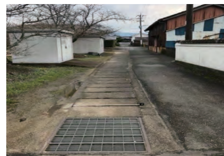
町道新田公民館1号線道路側溝改修工事
