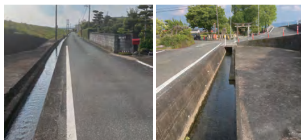
道路改良工事实施予定の西網道南鹿野2号線
