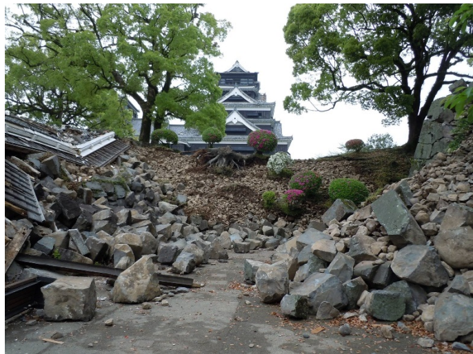
図 平成28年熊本地震による被害
