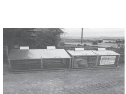
ゴミステーション整備
