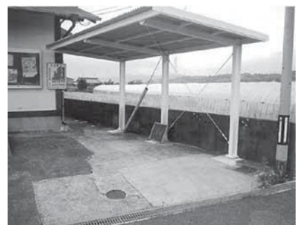
公民館駐輪場整備
