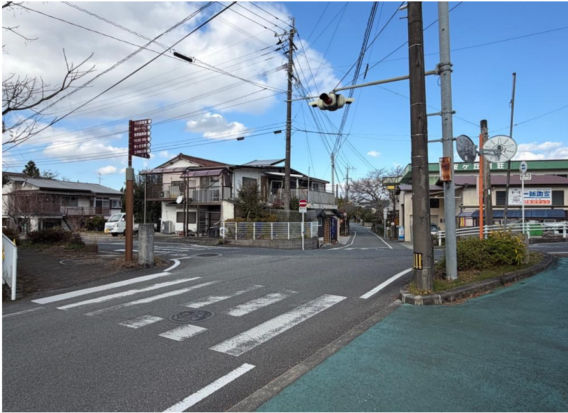
②宮原小学校周辺交差点（宮原小） （現状） 一灯式信号機の老朽化が進んでおり 危険である。
