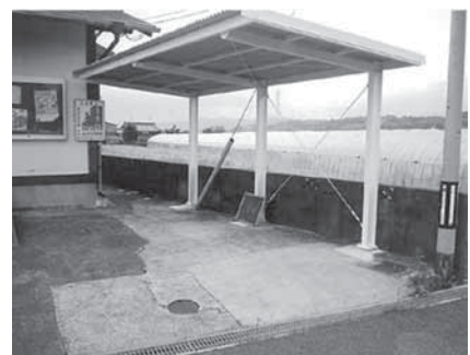
公民館駐輪場整備
