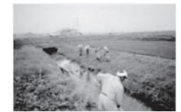
水路の泥上げ （日常の管理）
