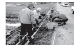
水路の補修 （施設の長寿命化）
