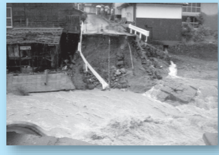
梅雨前線による豪雨で河川が氾濫した豪雨災害。美里町では道路寸断、土砂崩れで集落が孤立した。
