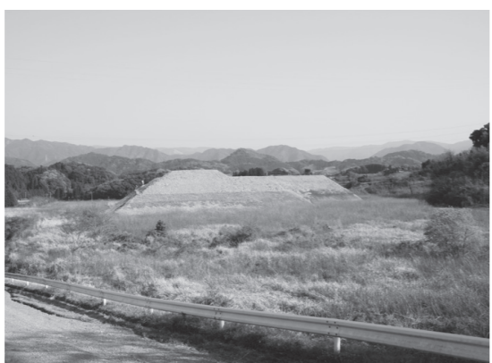
準備が進むスマートインターチェンジ建設予定地
