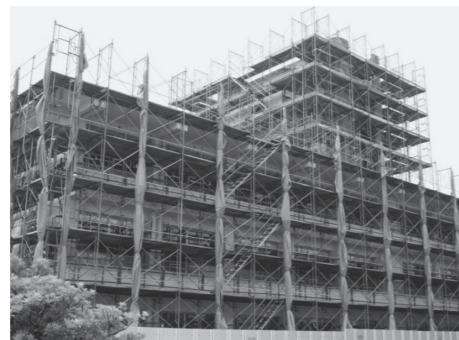
▲耐震工事中の校舎
