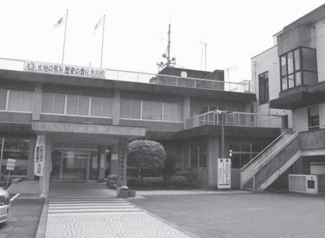
▲八火図書館との複合化に伴い解体・改造工事が行われる宮原振興局
