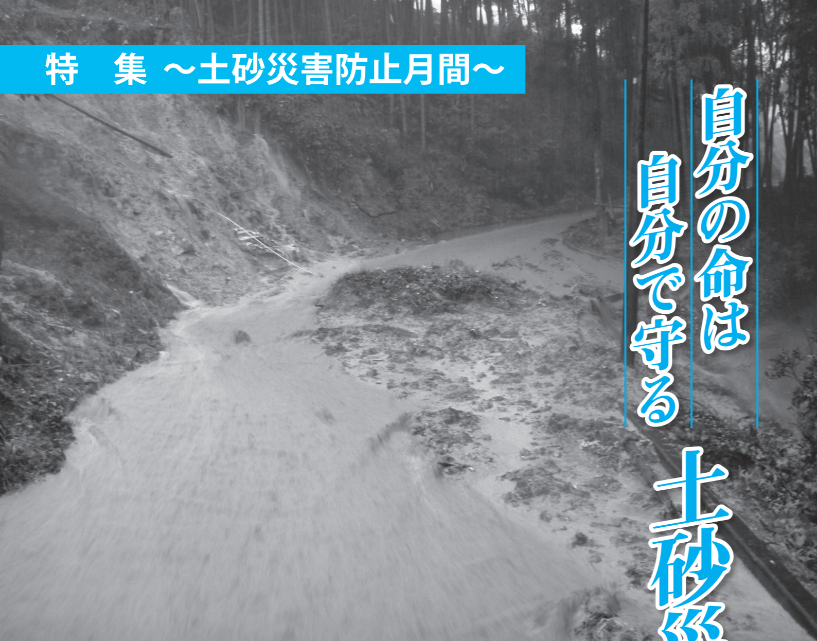
平成19年7月の集中豪雨により「がけ崩れ」が発生（油谷地区）
