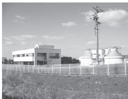
▲宮原浄化センター
