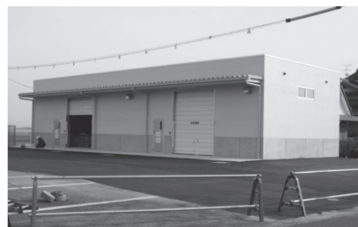
▲建設中の備蓄倉庫(学校給食調理場東側)
