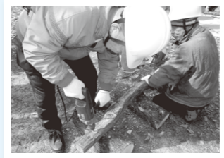
▲電動ドリルで穴開け
