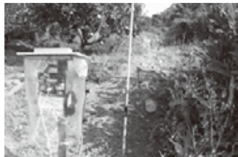
▲設置された電気柵
