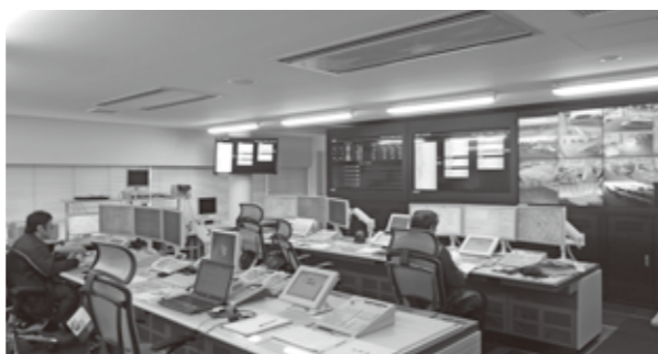
▲高機能消防指令センター
