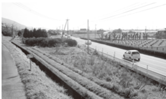
▲鏡消防署氷川分署の建設予定地
