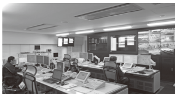
▲高機能消防指令センター
