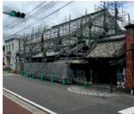
▲工事中のまちづくり酒屋
