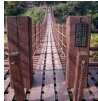
▲塗装してきれいになった龍神橋
