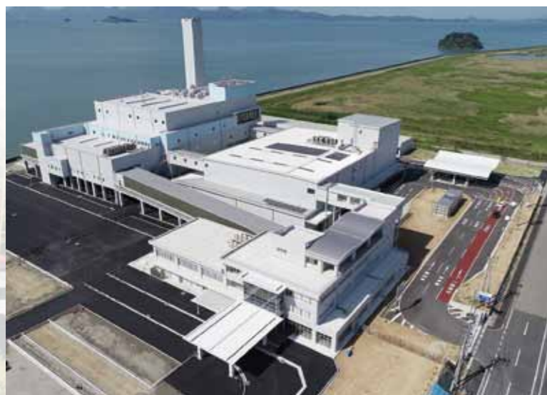
▲八代市環境センター「エコイトやつしろ」※写真は八代市提供
