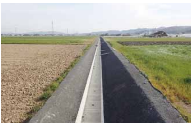
▲農業用排水路の改修 (写真は野津地区)
