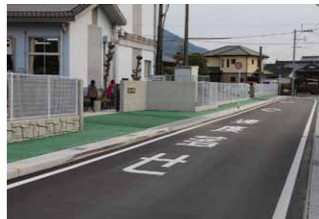
▲歩道と道路を整備した宮原小学校の校門前
