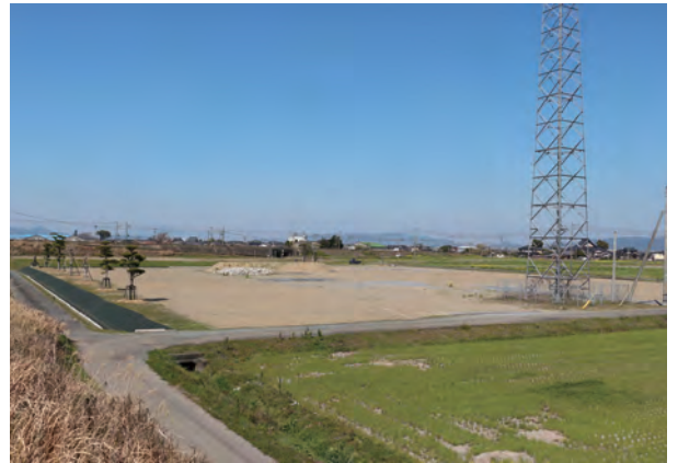
建設中の野津防災公園
