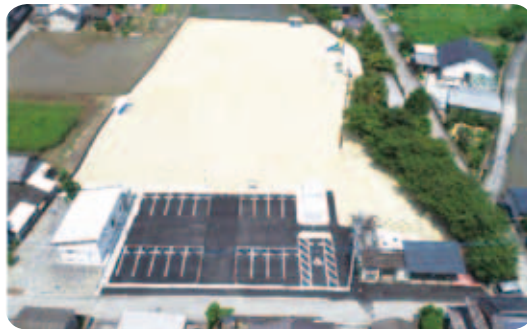
▲敷地面積約4,934㎡の公園が完成
