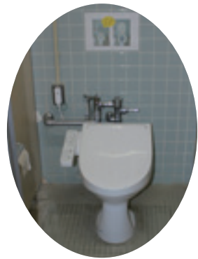
小中学校のトイレ改修
