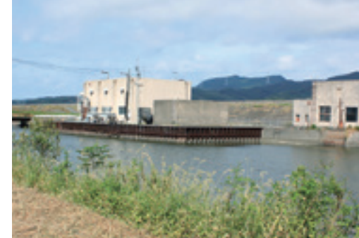
若洲排水機場
