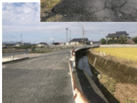
旧国道2号線改良工事予定地
