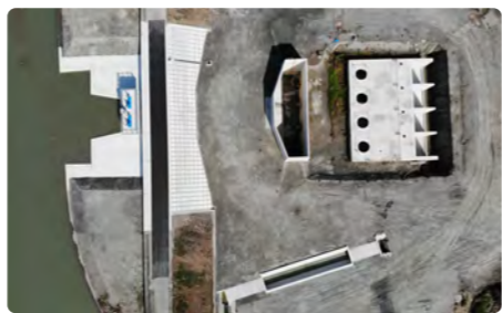
竜北地区（氷川）排水機場の下部工と排水樋門の竣工
