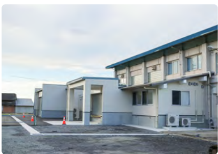
改修が完了した 学校給食共同調理場
