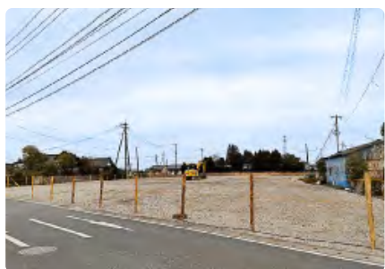
解体工事が完了した 氷川警察署跡地
